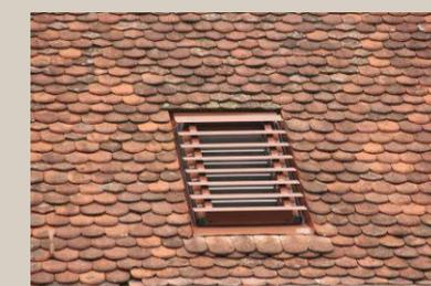
Farblich angegliche, vorgesetzte Lamellen aus Aluminium verkleiden das an die Dachneigung angepasste eingebaute Dachfenster.
