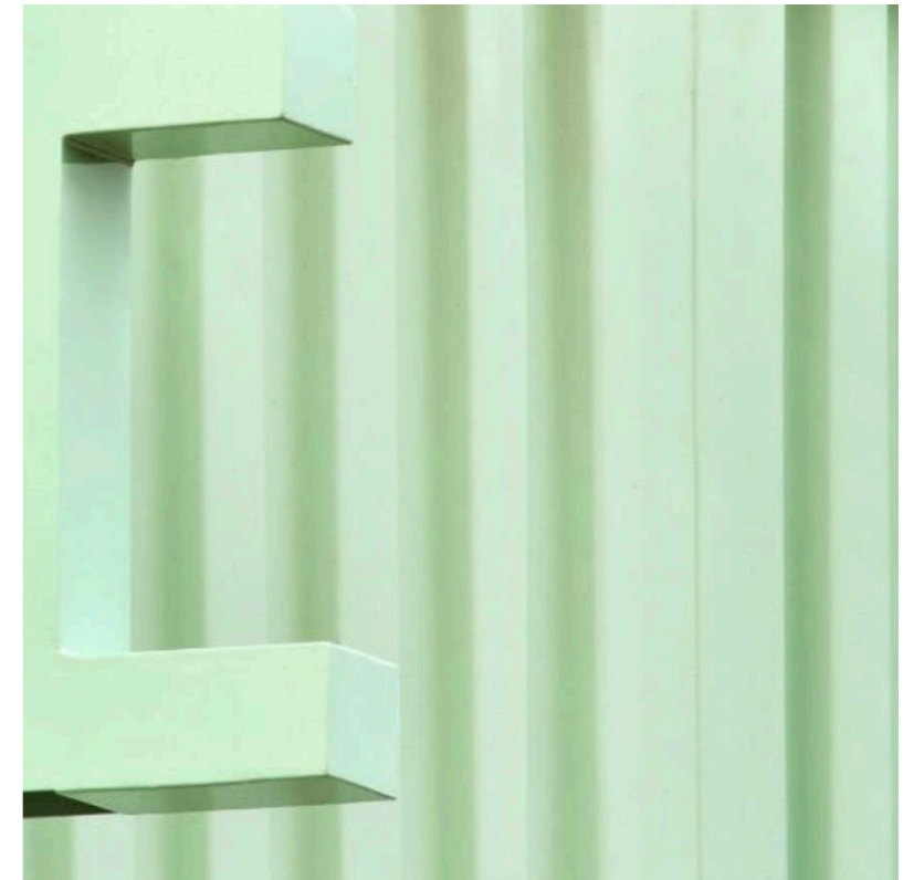
lackierter Stahl | Arkadenkonstruktion
