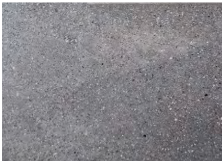
Boden geschliffener Estrich
