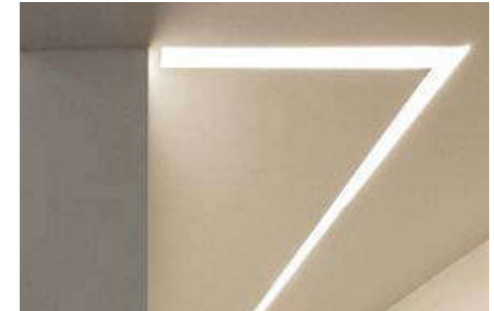
Leuchten, in Decke eingelegt
