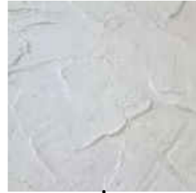
abgehängte Decke Kellenstrichputz
