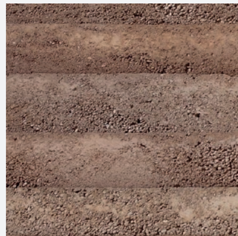
Stampfbeton. Reparatur und Weiterbauen.
