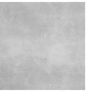
geschliffener Estrich Bodenbelag
